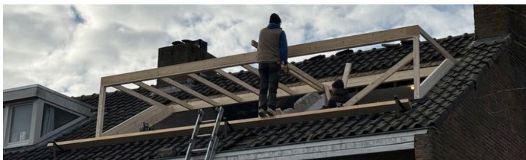
CONSTRUCTIE EN HOUTEN SKELETBOUW TIMMEREN
