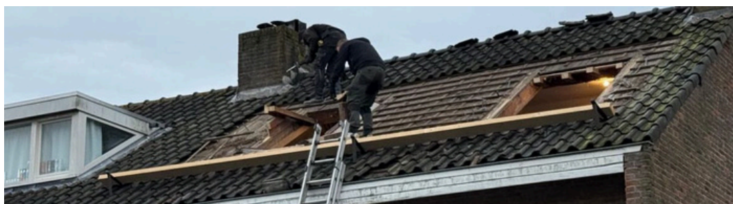
SLOPEN VAN 2 OUDE DAKKAPELLEN EN HET GAT UITZAGEN VOOR DE NIEUWE DAKAKPEL
